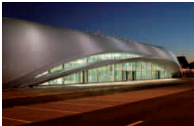
Odbavovací hala letiště Brno - Tuřany
