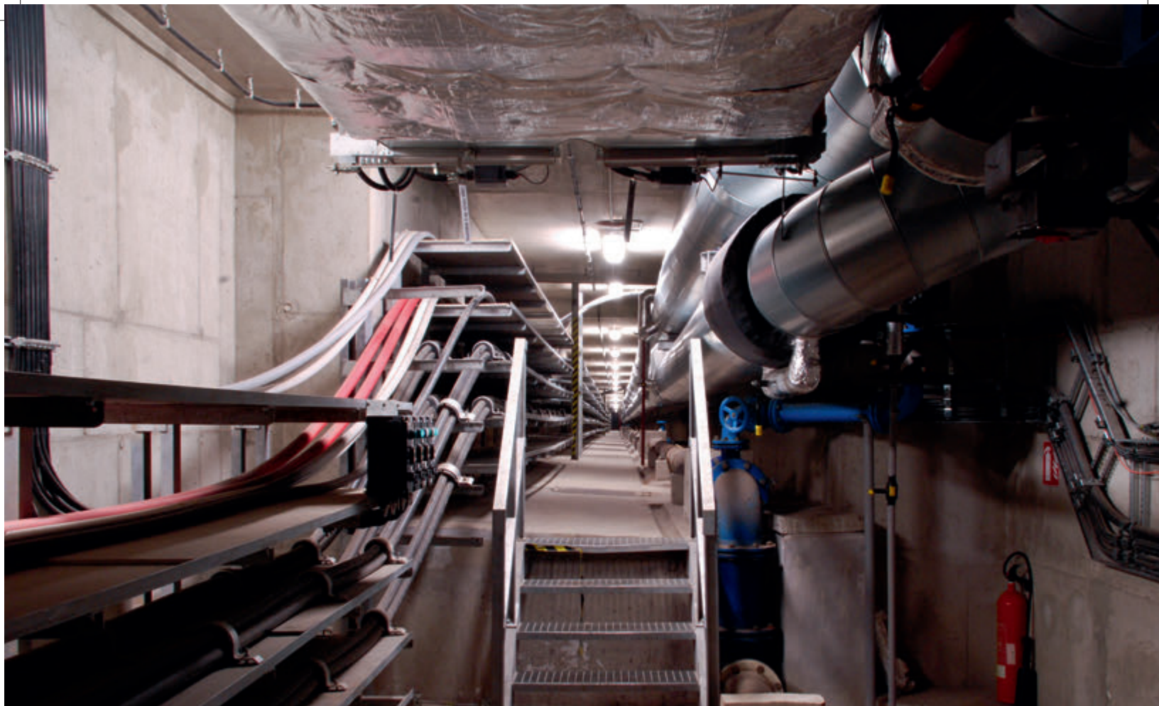
Hloubené sekundární kolektory – Jižní centrum
