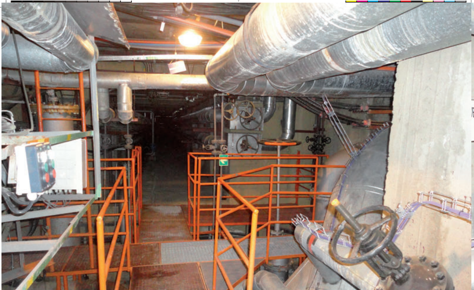
Hloubené sekundární kolektory - Vinohrady
