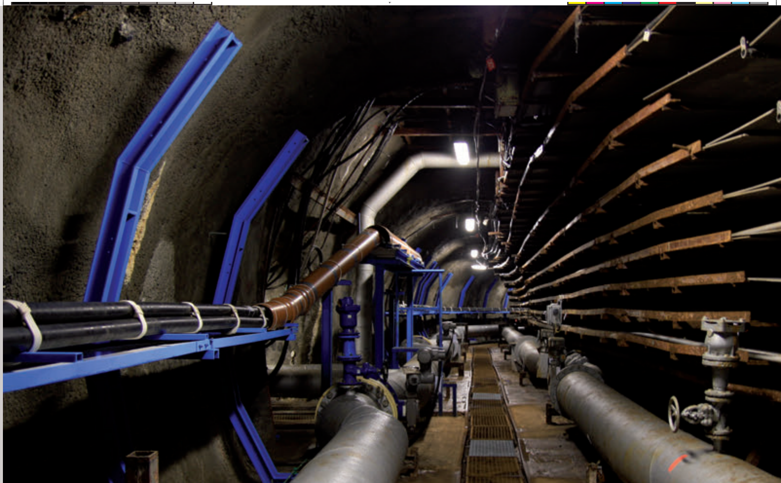
Ražené primární kolektory - ul. Křenová
