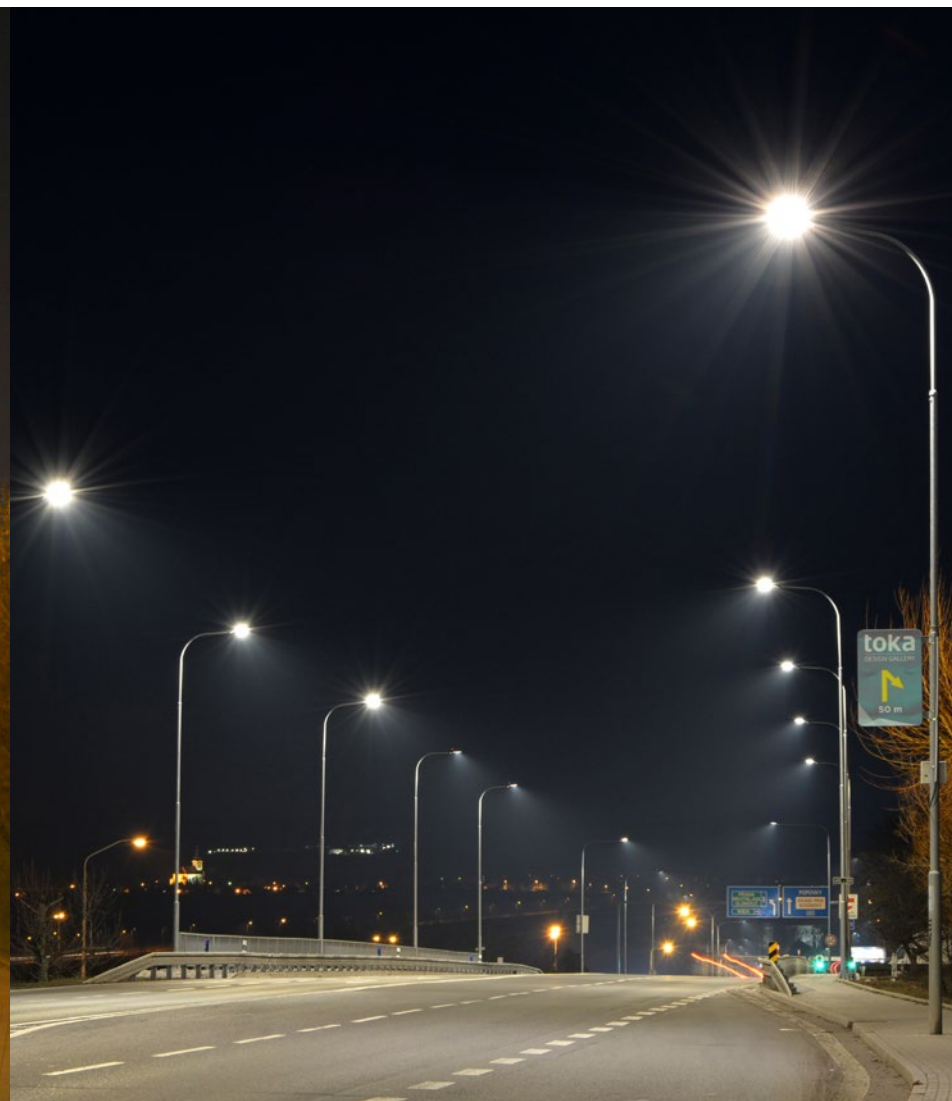
Ul. Jihlavská po rekonstrukci.
